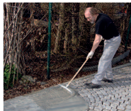
Zalévání PCI Pavifix® CEM pomocí gumové stěrky do spár.
