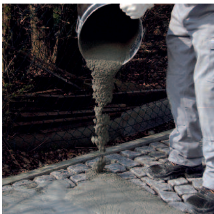
Nanášení malty PCI Pavifix® CEM na spárovanou plochu.
