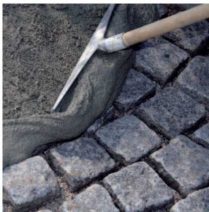
Vpravení malty do spár pryžovou stěrku metodou vtlačování.
