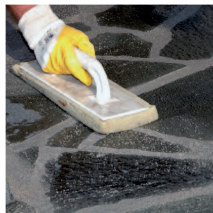
Do jedné hodiny se povrch spárované plochy omyje vlhkou houbou.
