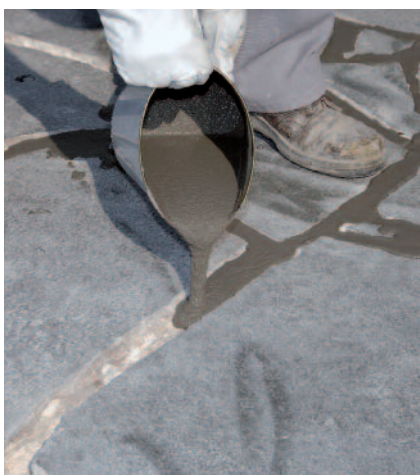
Nalévání malty PCI Pavifix® CEM vhodnou nádobou do spár.
