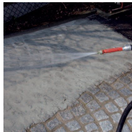
Čištění povrchu téměř vodorovným vedením vodního paprsku, nutno zabránit nechtěnému vyplavení malty ze spár.
