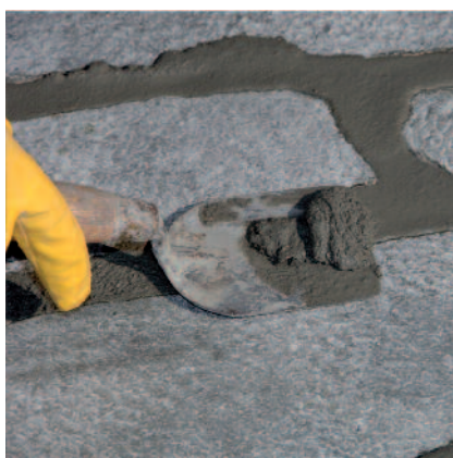
Odstranění přebytečné malty zednickou lžící.
