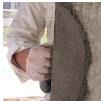
Oprava rohů a hran - je jen jedním z mnoha využití univerzální opravné malty PCI Nanocret® R2.
