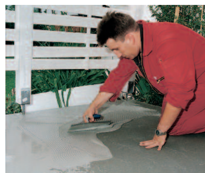
Pružnou izolační stěrku PCI Seccoral® 1 K je možné na stěnu nebo podlahu nanést válečkem nebo roztáhnout hladítkem.
