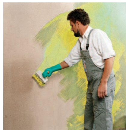
Nátěr PCI Wadian® chrání dřevěné konstrukce před vlhkostí a umožňuje jejich obkládání s použitím PCI lepidel.
