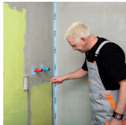
3. Provádění pružné hydroizolační vrstvy (např. PCI Lastogum®, aj.) nátěrem ...
