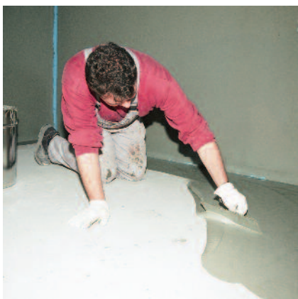
4. ... nebo stěrkováním (např. PCI Seccoral® 1K, PCI Seccoral® 2K Rapid, aj.) ...
