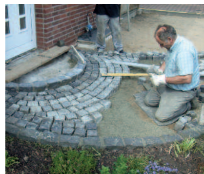
Pokládka kamenných kostek do vrstvy PCI Pavifix® DM
