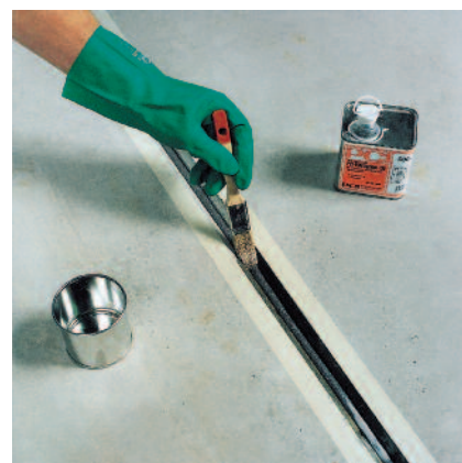
Očištěné okraje před spárováním spár natřít dosyta penetrací PCI Elastoprimér 110.
