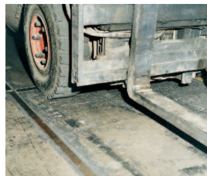
PCI Elritan® 140 na spáry v průmyslových a skladovacích halách.
