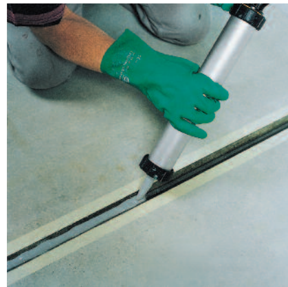
Nejdříve za 50 min a nejpозději za 2 hod. po penetraci uzavřít podlahové spáry pomocí PCI Elritan® 140.
