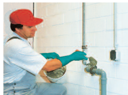
Blesková cementová malta PCI Polyfix® 5 Min. se rychle zpracovává a smíchá se jenom s vodou.
