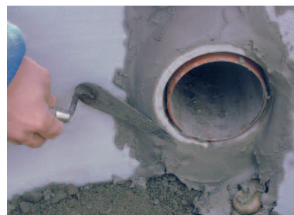
Šachtový vtok ukotvený maltou PCI Polyfix® plus.
