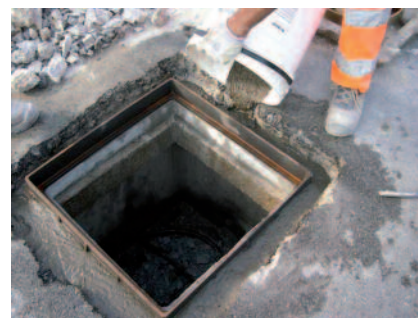
Osazování rámců kanalizačního poklopu maltou PCI Repafast® Fluid.
