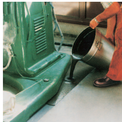
PCI Repaflow® je samonivelační a vyplňuje vodorovné dutiny.
