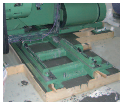
Pomocí zálivky PCI Repaflow® je zatížení dokonale přenášeno do podkladu.
