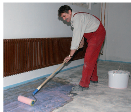
PCI Gisogrund® Rapid se nanáší neředěný rovnoměrně pěnovým válečkem na minerální podklad. Po vytvoření filmu lze okamžitě aplikovat další vrstvy.
