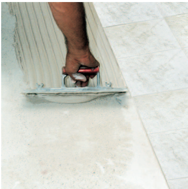
PCI Carrament® je plastické a pružné lepidlo, které se snadno nanáší.
