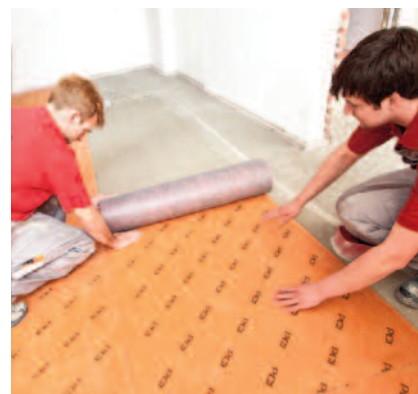
Na PCI Pecilastic® U lze díky překlenovacím a izolačním vlastnostem bezpečně a funkčně lepit keramické dlažby.
