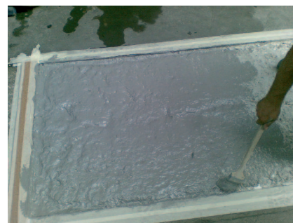
PCI Repahaft® EP poskytuje vynikající přilnavost mezi starým betonem a čerstvou maltou.
