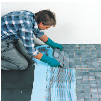
Dlažba je pokládána a srovnávána do lepidlového lože.
