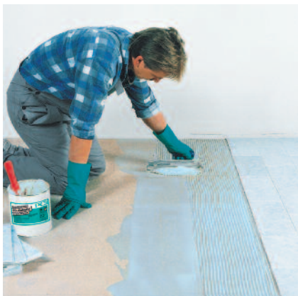
PCI Collastic® je vhodný pro podklady citlivé na vlhkost jako např. dřevotříska, OSB desky a pod..
