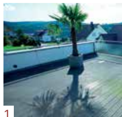
1. Terasa v původním stavu
