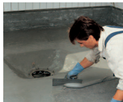
Nanášení PCI Apoflex® F pod keramický obklad velkokuchyně.
