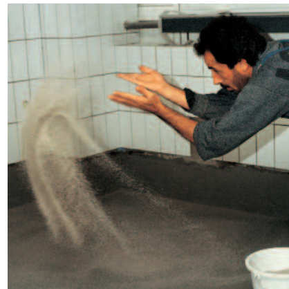
... a čerstvou zasypat křemičítým pískem (frakce 0,3–0,8 mm).
