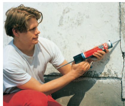
Trhliny v omítce mohou být snadno uzavřeny pomocí tmelu PCI Adaptol®.
