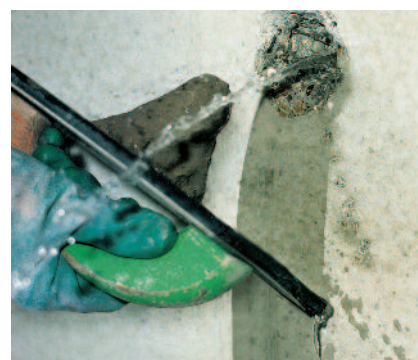
Bleskovou montážní maltou PCI Polyfix® 30 Sek. je možné rychle utěsnit průsaky vody.
