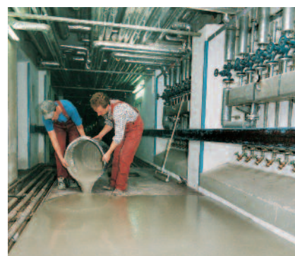
Applikace samonivelačního potěru PCI Zemtec® 1K.
