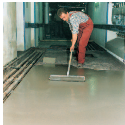
Nanášení výrobku PCI Zemtec® 1K na zavadlý (nikoliv zaschlý) penetrační nátěr, jeho samotná distribuce po ploše a odvzdušňování za pomoci válečku s trny (ježku).
