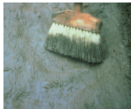
PCI Barraseal® CL se nanáší širokým štětkem ve dvou na sebe kolmých vrstvách.
