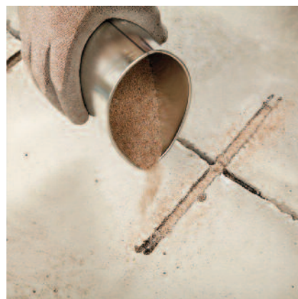
Následně zasypat křemičitým pískem frakce 0,3 až 0,8 mm.
