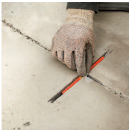
Vložit PCI Apogel® Dübel do vyříznuté drážky.
