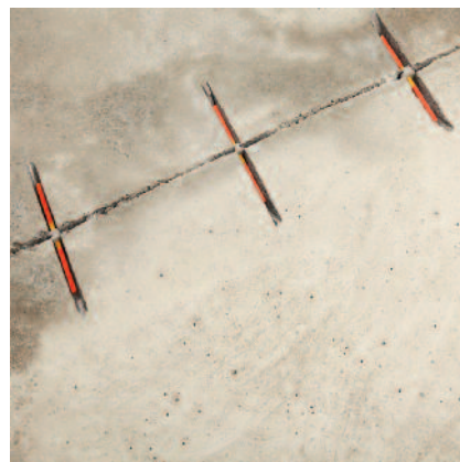
Pouze tři kusy PCI Apogel® Dübel stačí pro zajištění dilatace mezi dveřními zárubněmi.
