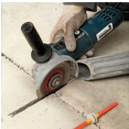
Potěr nařezat kolmo na dilatační spáru v rozestupu cca 30 až 40 cm.
