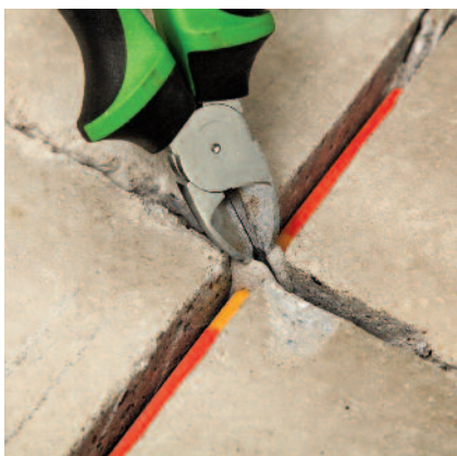
Přeštipnout plastový kroužek okolo pěnové výplně.
