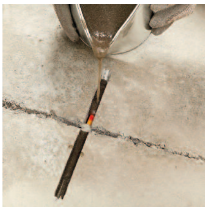
Spáru s vloženým kluzným trnem PCI Apogel® Dübel vyplnit směsí z PCI Apogel® SH.
