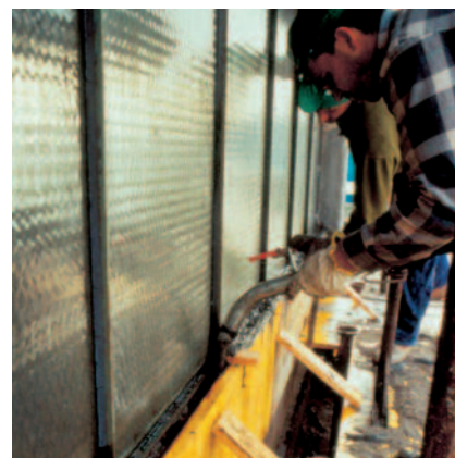
PCI Nanocret® R4 Fluid je vhodný pro rozsáhlé opravy betonu litím do bednění.
