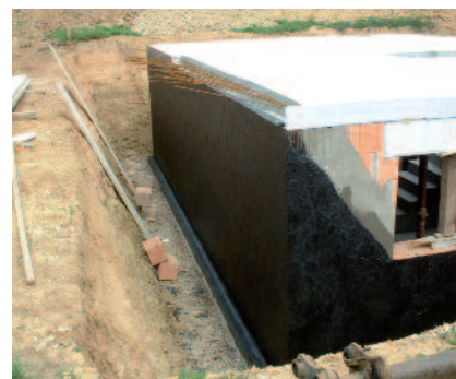
Izolace vnější zdi sklepa z betonu s PCI Pecimor® 2K. Snadné zpracování díky obsaženým polystyrénovým částicím.
