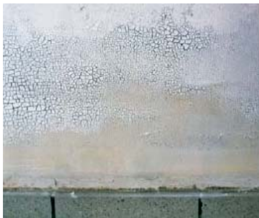
Nanesená vrstva čisticího prostředku PCI Entöler navázala znečištění a po vysušení okorala – snadno se odstraní.
