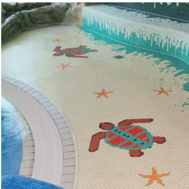
Materiály PCI Durapox® NT a PCI Durapox® NT plus jsou vhodné pro spárování mozaiky v plaveckých bazénech.
