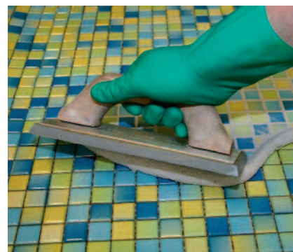
S materiály PCI Durapox® NT a PCI Durapox NT® plus je zaspárovaná plocha mozaiky chemicky odolná a vodonepropustná.
