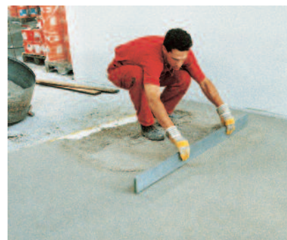
Zhotovení průmyslového potěru PCI Bauharz, odolného vůči oděru a chemikáliím.
